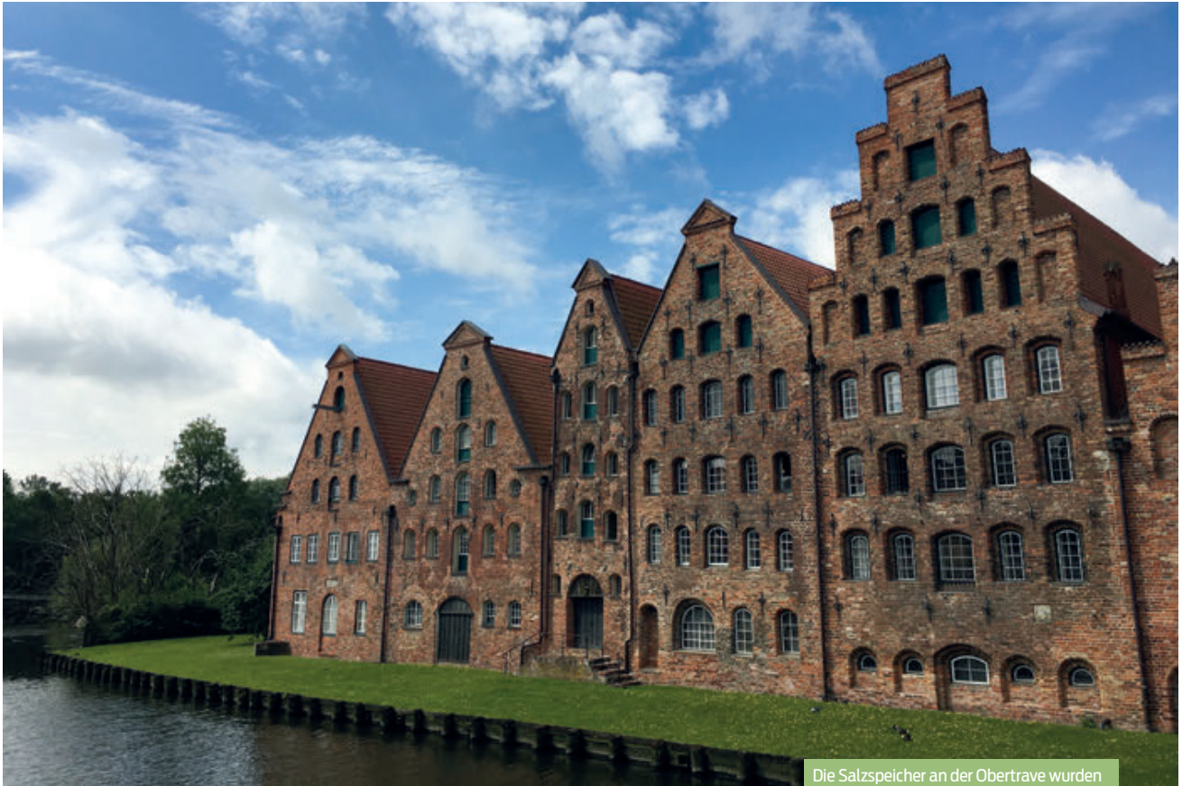
Die Salzspeicher an der Obertrave wurden zwischen 1579 und 1745 erbaut
